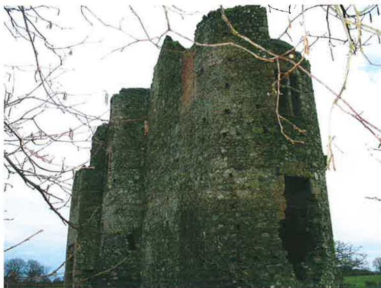
Les Hayes Gasselins : ruines.
